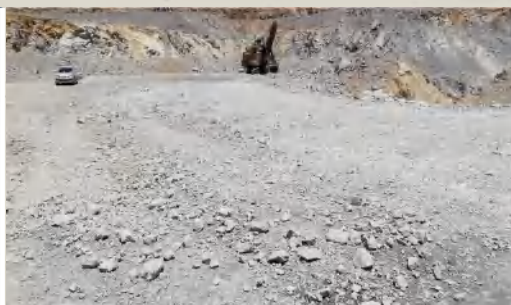
Плохие дорожные условия - просыпи
